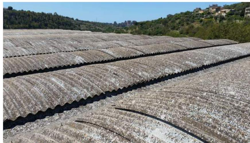
Copertura con travi prefabbricate in c.a. precompresso a Y e cupoloni in lastre di fibrocemento con amianto
